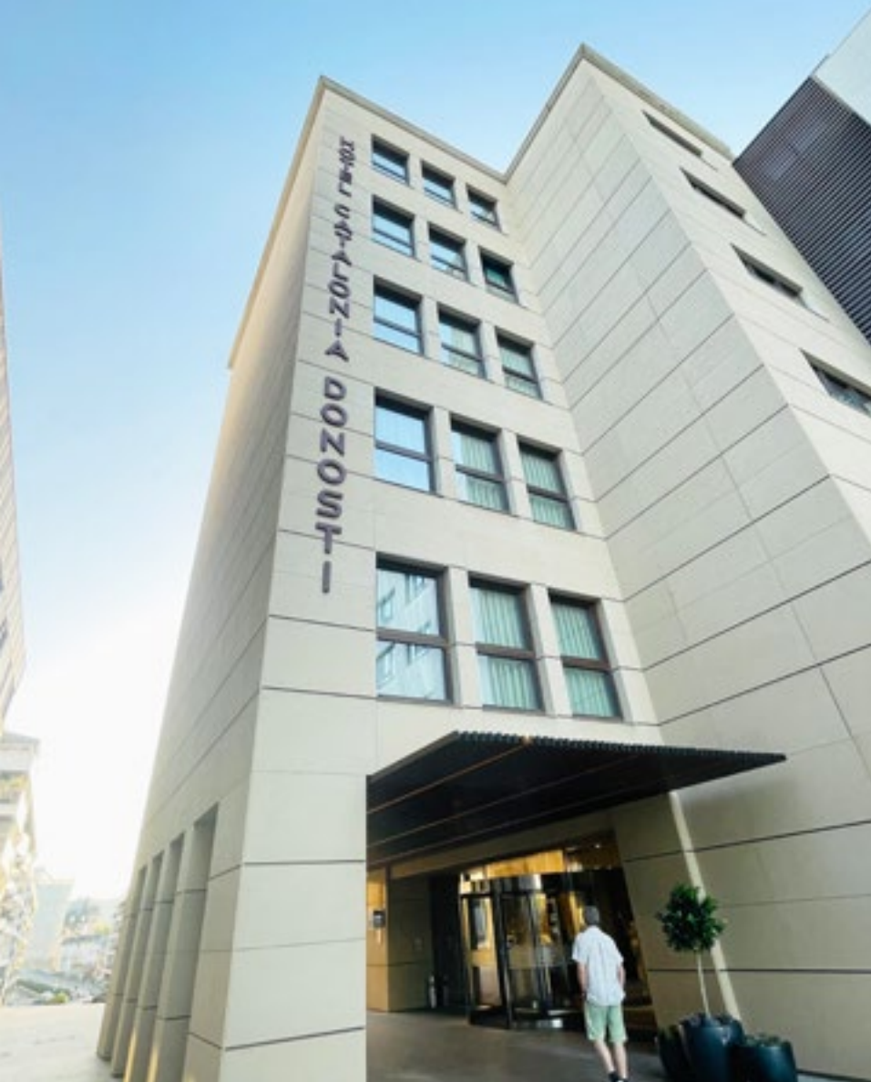
Fachada nueva del Hotel Catalonia Donosti
