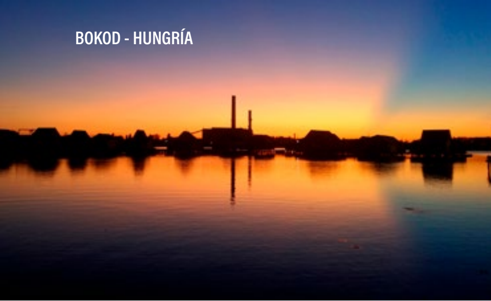
Vista de la Central al atardecer
