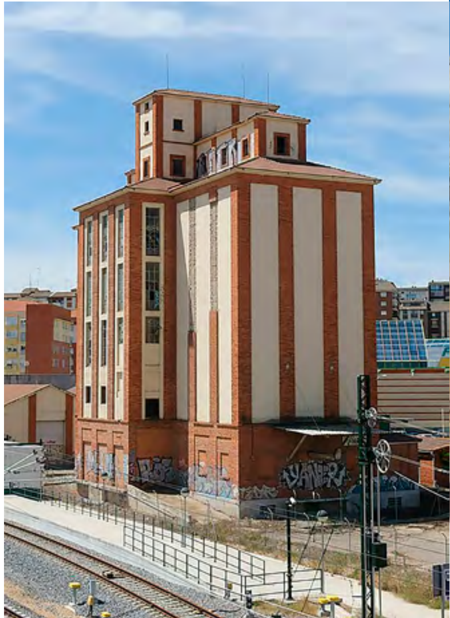
Los Silos de Zamora
