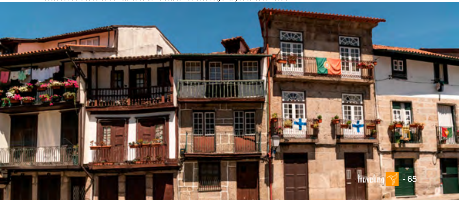
Casas tradicionales del centro histórico de Guimarães, con fachadas de granito y balcones de madera
