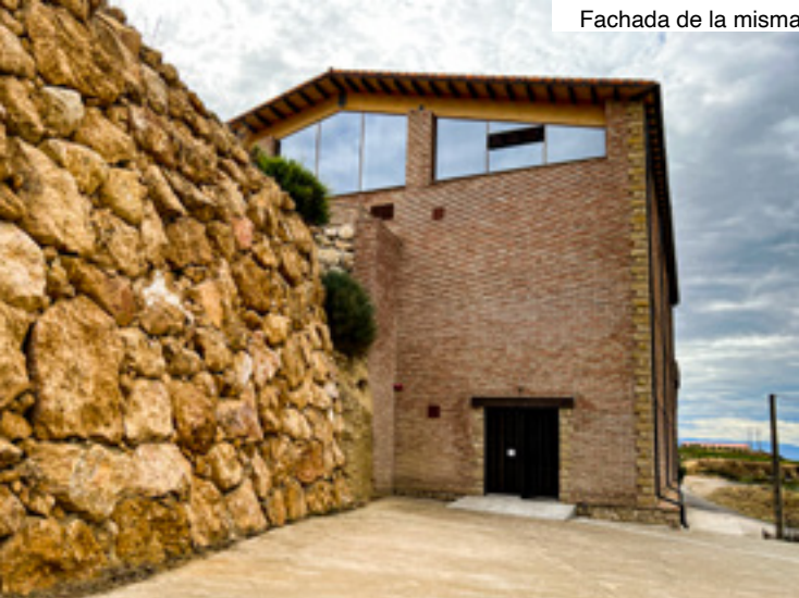
Interior de la bodega Fachada de la misma
